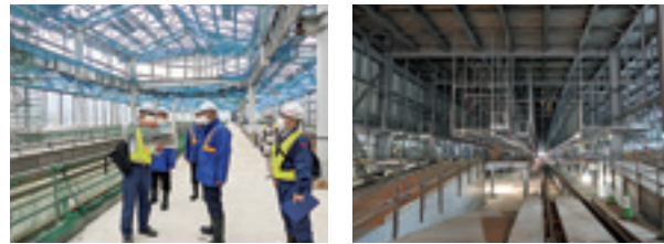
新幹線ホーム 敦賀車両基地
