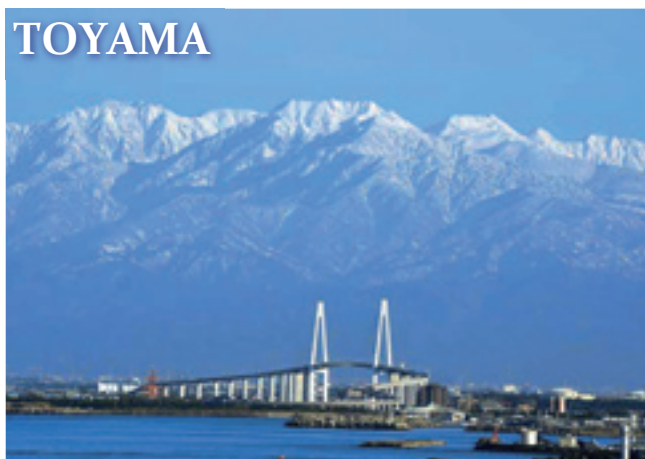
立山連峰・新湊大橋
